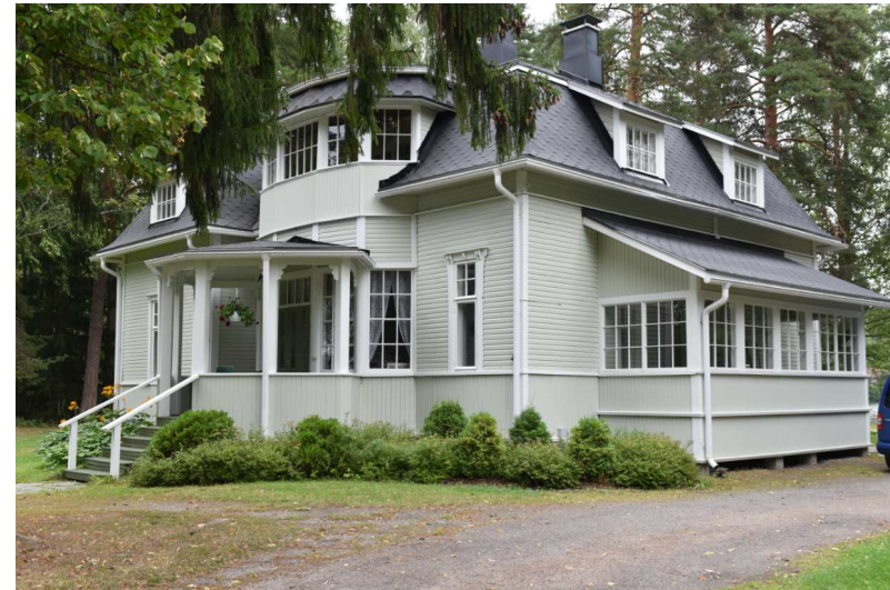
Kuva: Rakennusta on uudistettu sisältä ja ulkoa. Pulttikattoista verantaa on lyhennetty ja portaikko muutettu edestä pätyyn. Kuistin etuseinän rakenteisiin liitetyt koristelut on poistettu. Rakennuksen väri on muuttunut kellertävästä vihreäksi.
