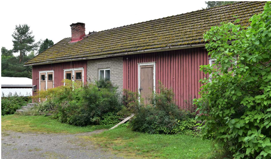
Kuva: Puu- ja betonitiiliseinäinen ulkorakennus. Saattaa olla osin hirttä.
