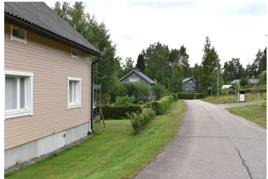
Kuva: Vallikadun puolitoistakerroksisia tyyppitaloja 1950-luvulta.
