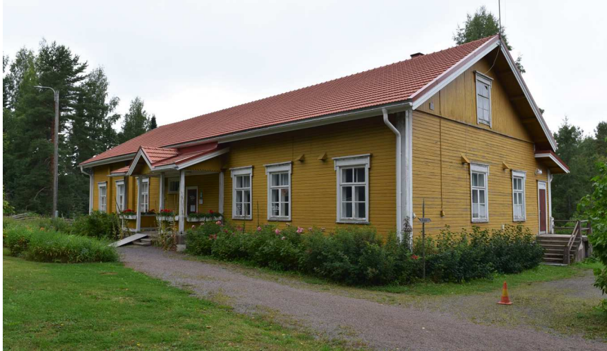
Kuva: Vanhan hallintorakennuksen julkisivuissa on keilapontti nurkkalaudoilla, ullakkopäädyissä on pystyлаudoitus. Ikkunat ovat sisään-ulosaukeavat; vaihteellinen rakentaminen näkyy ikkunoiden puitejaossa. Vesikatto on uusittu betonitiilestä. Kivisokkelin pinnassa on betonikuori. Avokuisti oi 20-luvulla harjakattoinen.
