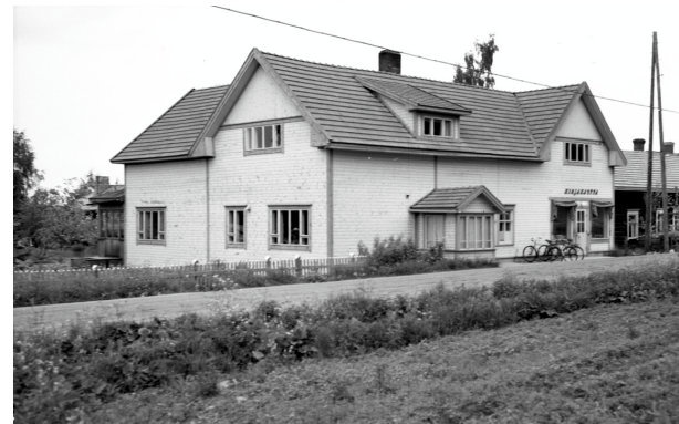
Kuva: Heinosen kauppatalo 1950-luvulla, laajennusten ja muutokorjausten jälkeisessä asussa. Kirjakaupan suuret näyteikkunat oli tehty jo 1942 mennessä. / Tmi Kotiseutukuva 1951. Lappeenrannan museot.
