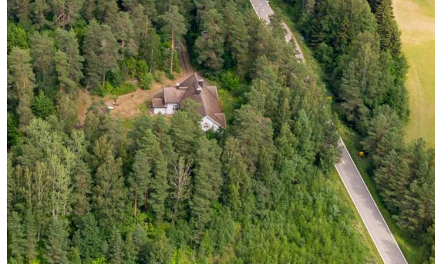
Kuva: Vanhan Viipuri–Savonlinna -tien suora linjausta varten on tehty kallioleikkaus talon itäpuolelle. Vanha linjaus kulki korkean ja matalan puuston rajalinjassa. / Viistokuva 2021.
