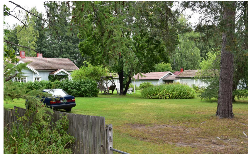
Kuva: Rantakatu 3a rakennettiin aikoinaan rantaviivan tuntumaan. Pitkässä harjakattoisessa talossa on yhtenäinen rimalaudoituus, betonitiilikatto ja kolme erilaista sisäänkäyntiä pääfasadissa.
