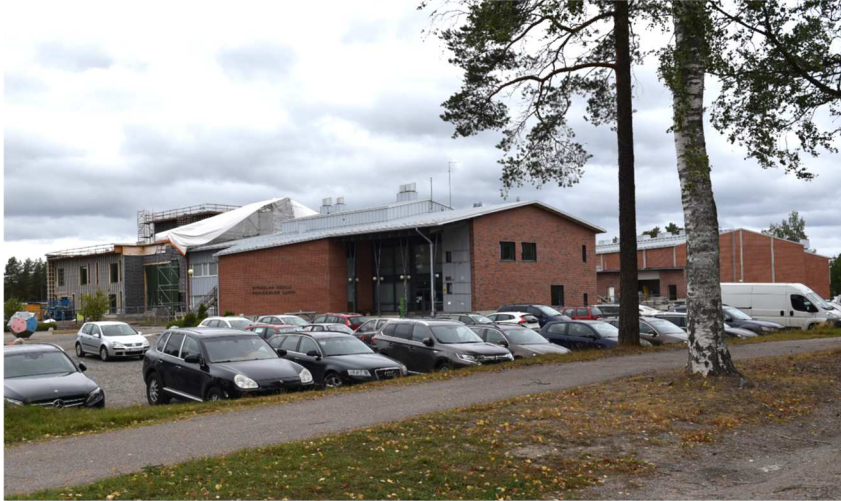
Kuva: Uuden koulun rakennustyöt ovat loppusuoralla.
