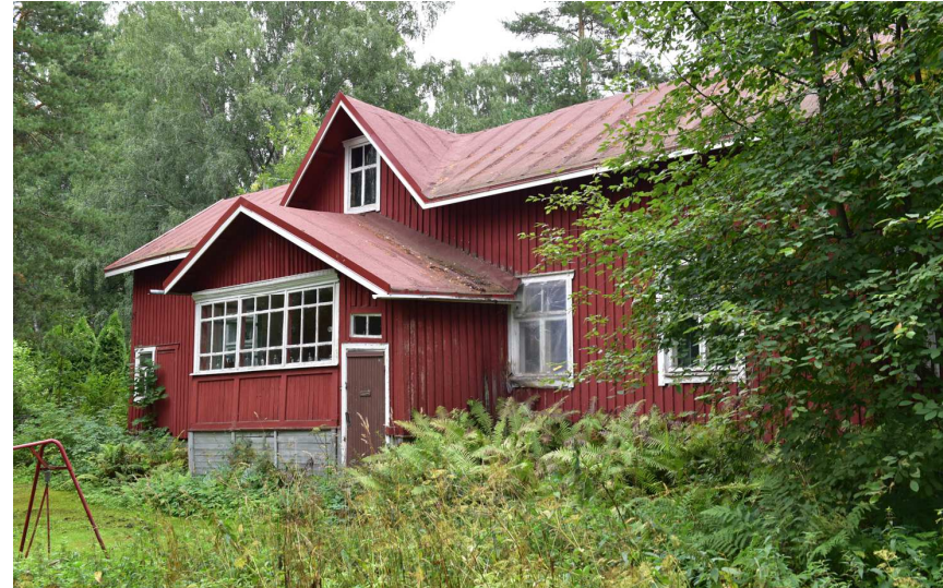
Kuva: Rakennuksen pihajulkisivussa on säilynyt vanha kuisti ja sen verkkoruutuinen ikkuna. Ikkunat ovat sisään-ulos-aukeavia.
