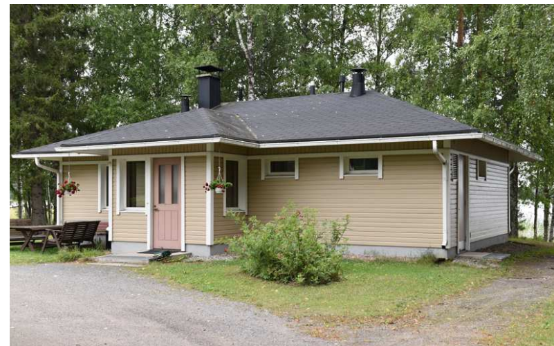
Kuva: Rakennusta on uudistettu sisältä ja ulkoa. Pulttikattoista verantaa on lyhennetty ja portaikko muutettu edestä pätyyn. Kuistin etuseinän rakenteisiin liitetyt koristelut on poistettu. Rakennuksen väri on muuttunut kellertävästä vihreäksi.
