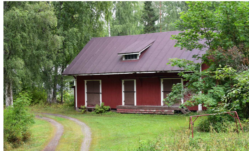
Kuva: Takapihalla on vanha makasiinirakennus: rimalaudoitus, huopakatto, betonipilariperustus, rautasalvoilla varustetut paneeliovvet.
