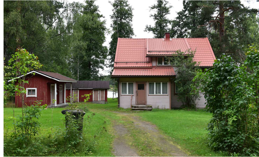
Kuva: Alkuperäistä luonnetta säilyttänyt sotien jälkeinen puutalo.
