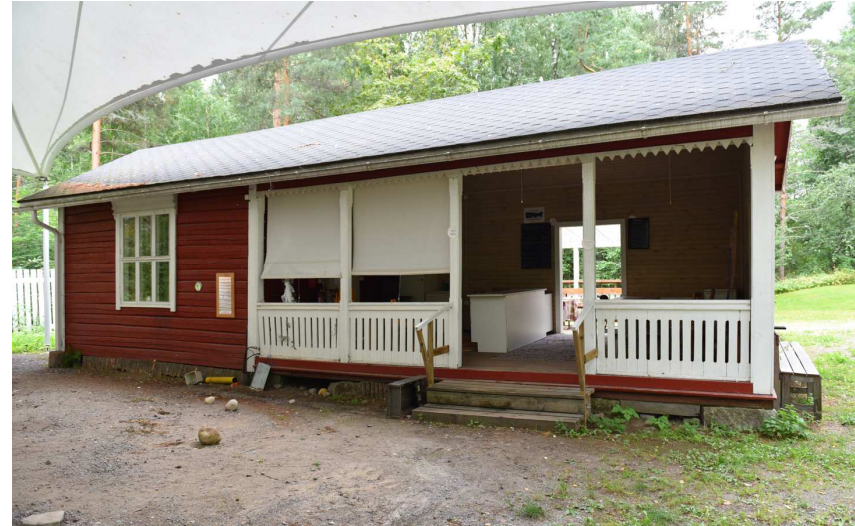
Kuva: Kesäteatteri näyttämörakennuksen toinen pääty on hirttä. Se on saatettu tehdä paikalla puretun Parikan talon ulkorakennuksesta. Näyttämörakennuksessa on käytetty vanhoja ovia ja ikkunoita, perustuksessa on lohkokiviä.
