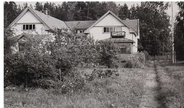
Kuva: Heinosen kauppakauppa 1950-luvulla rannasta päin kuvattuna. Pihan puolen julkisivuissa on säilynyt vanhalla karmi- ja puitejaolla olevia ikkunoita. / Olavi Heinosen julkaisu 2017, s. 17.
