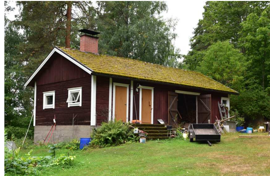
Kuva: Pihapiirissä on säilynyt hirsi- ja lautarakenteinen ulkorakennus.
