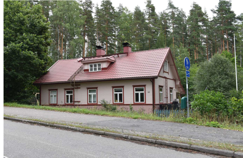
Kuva: Rakennuksen tyyli ajoittaa sen 1800- ja 1900-lukujen vaihteeseen. 28 Julkisivuissa on vanhaa ja uutta. Yläkerran ikkunat ovat vanhat sisään-ulosaukeavat. Verhoustapa on säilynyt. Vesikate on vaihdettu profiilipeltiin. Lisärakentaminen on tehty pihan puolella, jossa uudet tilat ja avoveranta on yhdistetty saman pulpettikaton alle.
