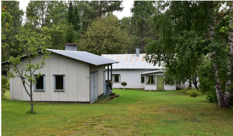
Kuva: Kirkkokatu 10:ssä olevat rakennukset on julkisivujen osalta modernisoitu. Talon hahmossa näkyy edelleen sen ikä.
