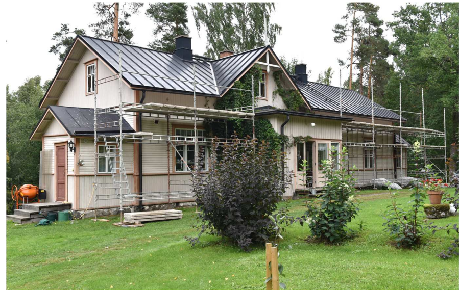
Kuva: Päärakennuksessa on tehty peltikattotöitä.
