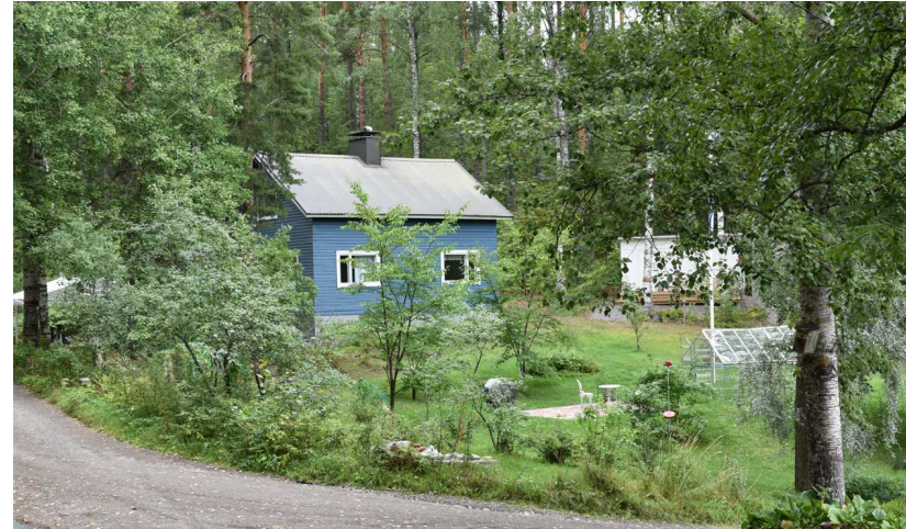
Kuva: Likolampi 1:n puutalo on sotien jälkeiselle ajalle tavanomainen harjakattoinen, noppamainen, vaakalaudoitettu tyyppitalo, jota on ehkä peruskorjattu 1980-luvulla, josta rakennusvuosi 1982 rekisteriin.
