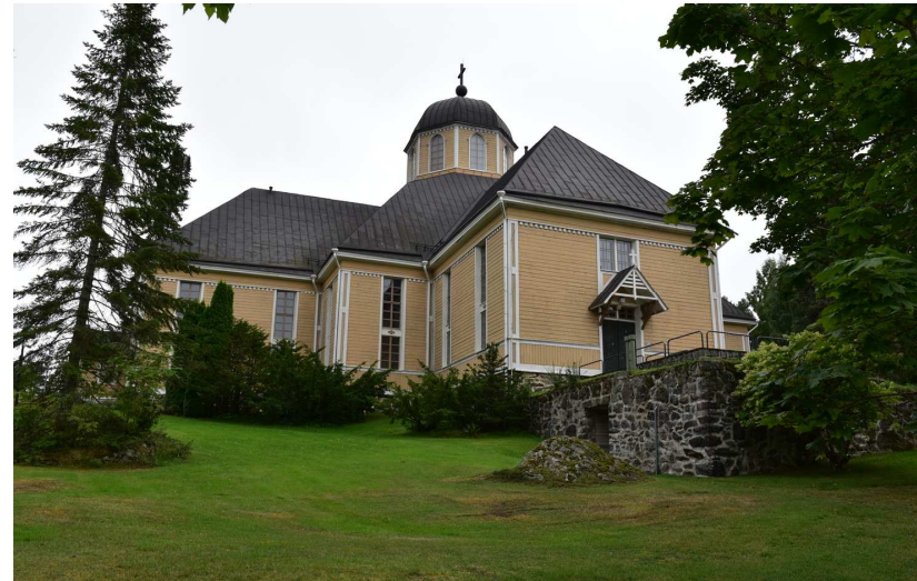
Kuva: Kirkon korkeat ikkunat, vyöhykkeinen verhous hammaslistoineen ja jyrkkäharjaiset ovikatokset ovat 1910-luvun muutoskorjauksesta. Pohjoissiiven edustalla olevassa kiviseinäisessä osassa on yleisö-WC.
