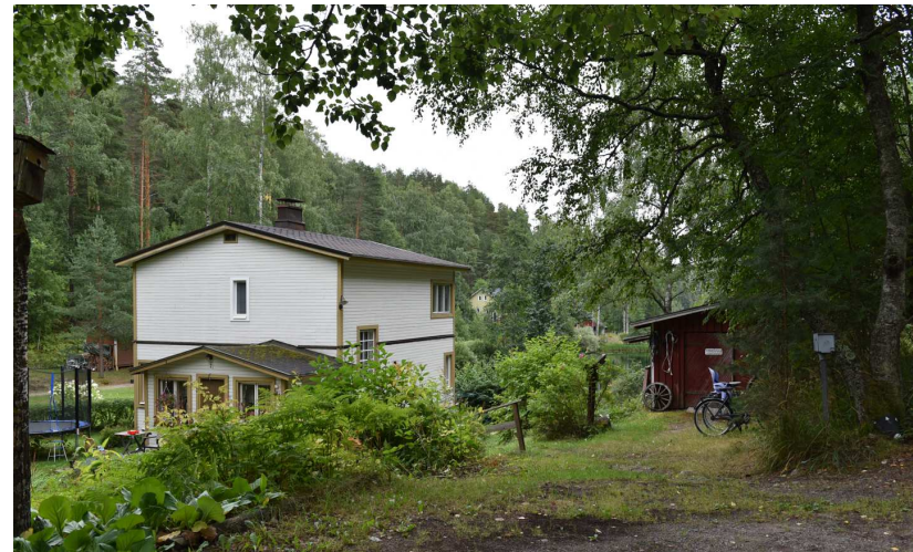
Kuva: Taloryhmän vanhin on Likolampi 2:ssa sijaitseva noppamainen puutalo vuodelta 1938. Välipohjan erottuminen julkisivussa viittäisi vaiheittaiseen rakentamiseen tai erikoisempaan vaakarakenteeseen. Kirkonkylän 1. pohjakarttaan katto oli piirretty nelilappeiseksi. Taaempänä näkyy Likolampi 3:n 1943 rakennettu puolitoistakerroksinen tyyppitalo.
