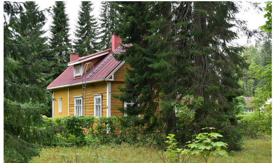
Kuva: Rakennuksen vanha osa on jätetty vuoraamattomaksi, laajennusosa on lautarakenteinen ja verhoiltu vaakapaneelilla. Talossa on vanhat sisäänulosaukeavat ikkunat ja niiden vuorilaudat. Sokkeli on näkyviltä osin betonia.
