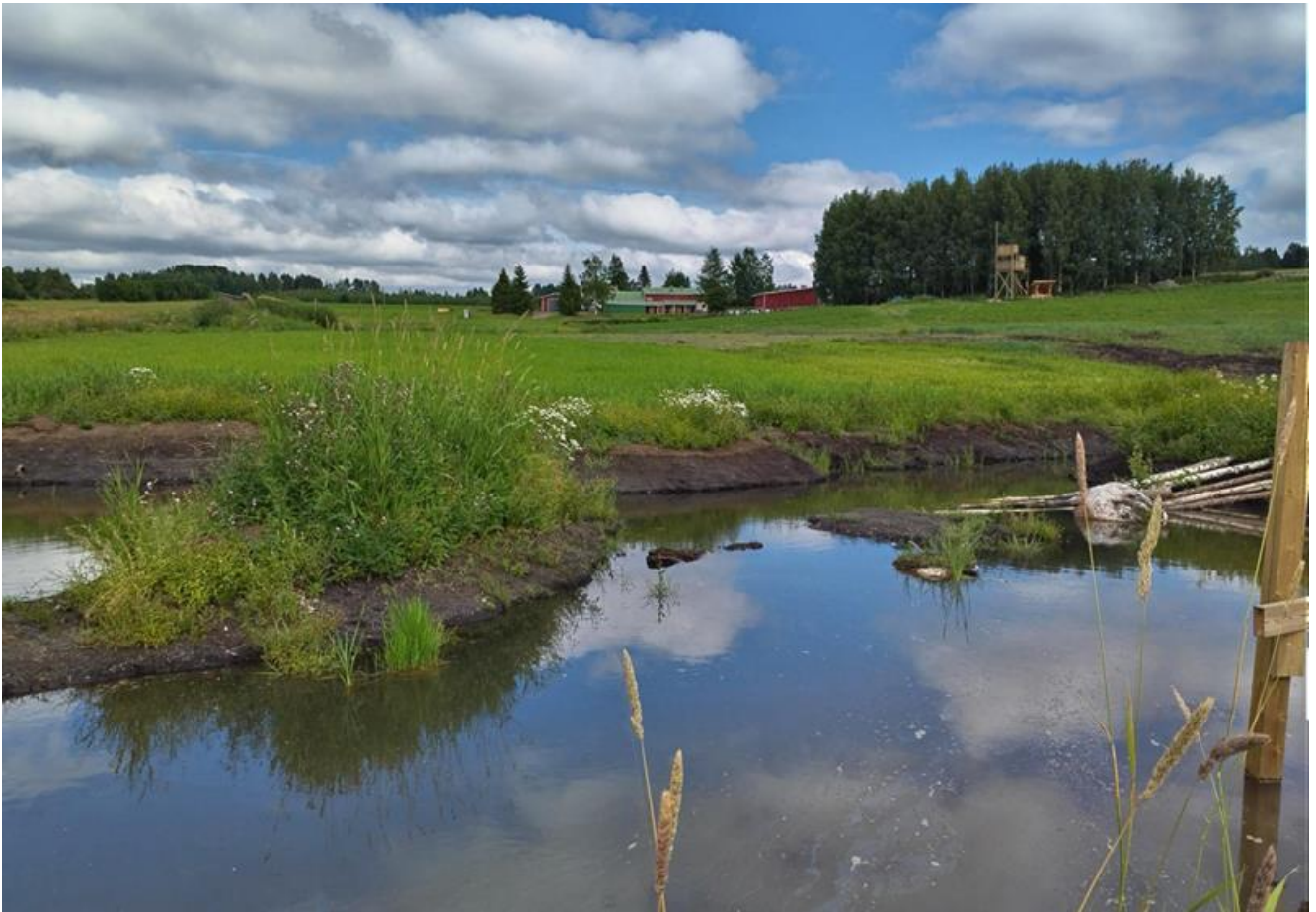
Kuva 7. Kuljakon Kostit' Opotta -kosteikko. Kuva kosteikosta rakentamisen jälkeiseltä ensimmäiseltä kesältä heinäkuulta 2024, jossa näkyy kosteikon yläpuolista valuma-aluetta ja maanomistajan metsän reunaan rakentama näkötorni ja laavu. Näkötorni sijaitsee viisaasti kauempana kosteikosta – tarkkailu etäältä ei häiritse lintujen pesimistä ja kosteikkoa pääsee tarkkailemaan jo aikaisin keväällä peltoalueen ollessa vielä kulkukelvoton. Vesi kosteikolla pidettiin ensimmäisenä kesänä lopullista tasoa alempana, jotta turvemaasta rakennetut patovallit kuivuvat. (Kuva S. Wilhelms)
