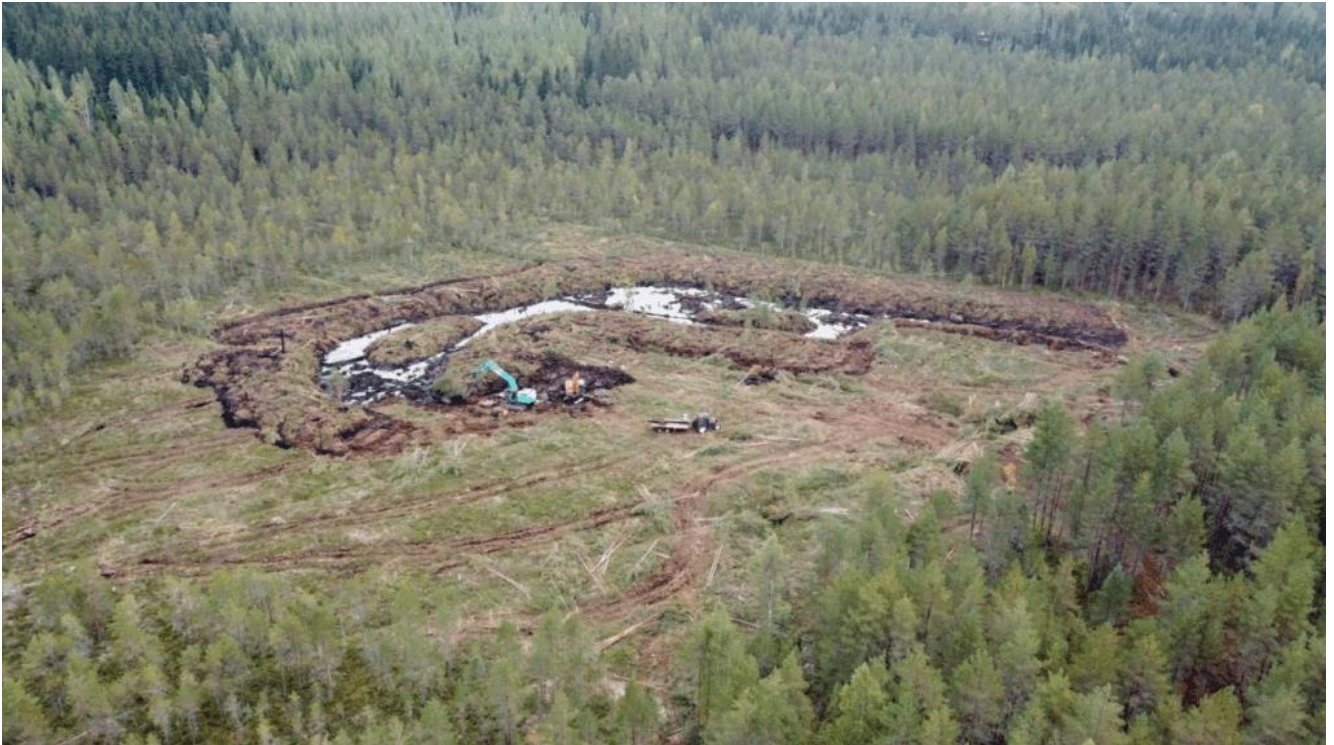
Kuva 13. Rakentamisaikainen ilmakuva kuivatyövaiheesta, jolloin kosteikkotyömaalle ei päästetty ulkopuolisesta ojastosta vesiä, eikä kosteikolta ollut vesiyhteyttä alaspäin laskevaan ojaan. Altaaseen oli tässä vaiheessa alkanut nousemaan pohjalle pieniä määriä vettä yhden ukkosaderintaman reunan osuttua alueelle. Kuva Juho Kokkonen, Suomen metsäkeskus.
