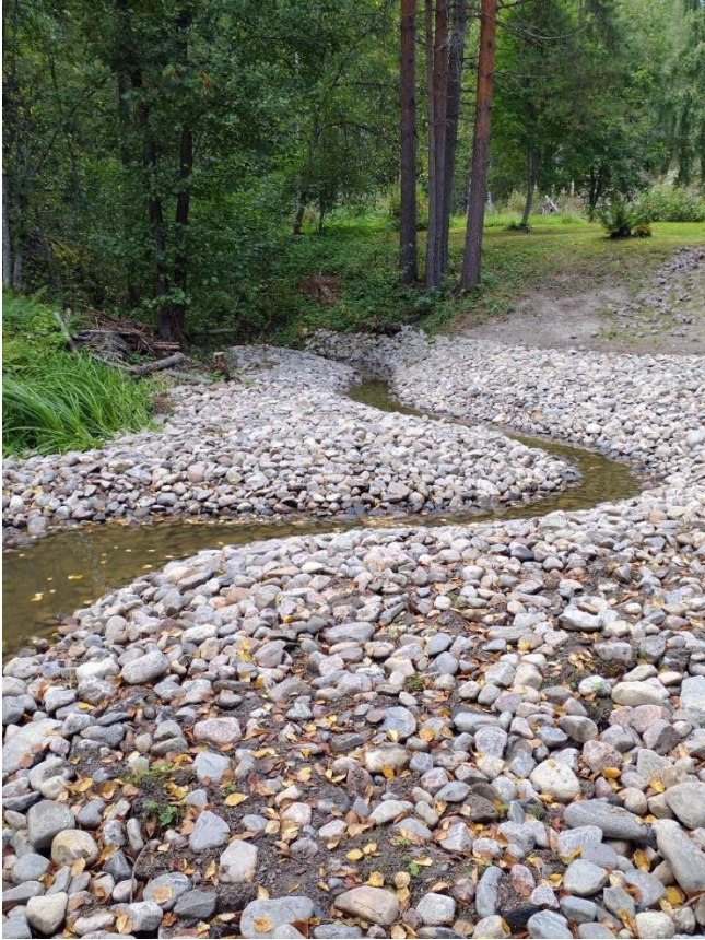
Kuva 3. Kokeellinen vesiensuojeluratkaisu kokonaisen tulvakennään kivipinnoitus-eroosiosuojaus järven vesijättömaan kevättulvavyöhykkeessä. Kuva S.W.
