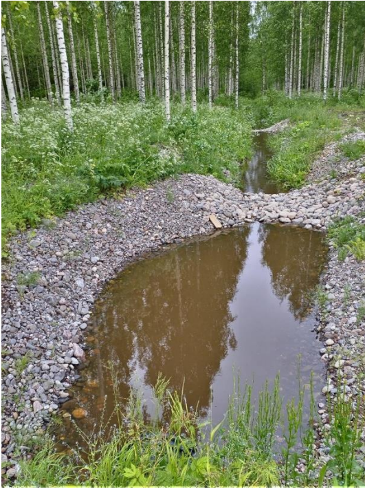
Kuva 6. Kurhonnurmen laskeutusallasketjun rakenteita 2025. Kuva SW
