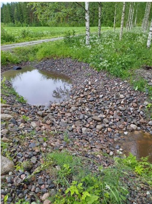
Kuva 5. Kurhonnurmen pienempiä laskeutusaltaita eroosiosuojattuna. Altaiden välissä virtaamansäästöpatoina vettä hapettavat kivipadot, joista kuuluu hieno solina. Kuva SW
