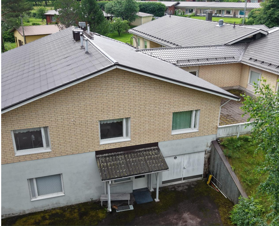
Ulkovaippa: tiiliverhousta, teräspeltikate
